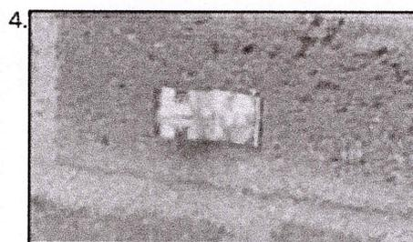
1. Utilice una broca espiral para mampostería con punta de carburo, del mismo diámetro que el remache [6,4 (.250) o 4,8 (.188)]. Taladre a cualquier profundidad, lo suficiente para permitir la inserción completa del remache.
